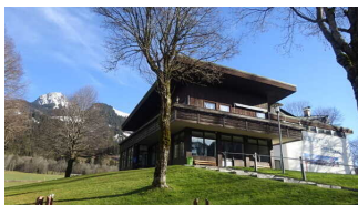
Talstation: Haupteingang / Kasse / Seilbahn Zugang innen
