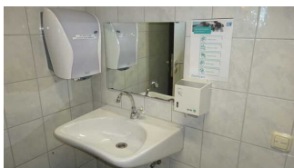
Bergstation: Öffentliches WC am Bergbahnhof Zahnradbahn
